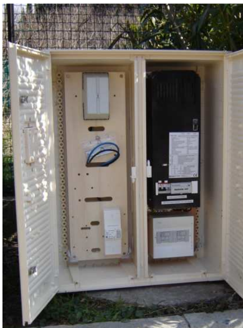
Exemple de montage en coffret de type S17 T3
